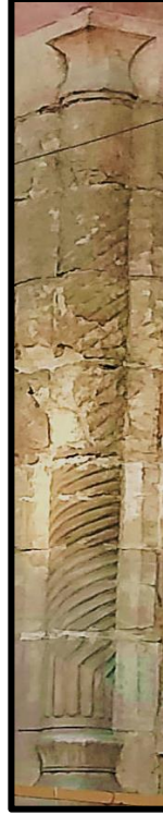
لوحة رقم (9): عمود مخلق بناصية احدى دخلات الواجهة الرئيسية لجامع المؤيد شيخ (تصوير الباحث)
