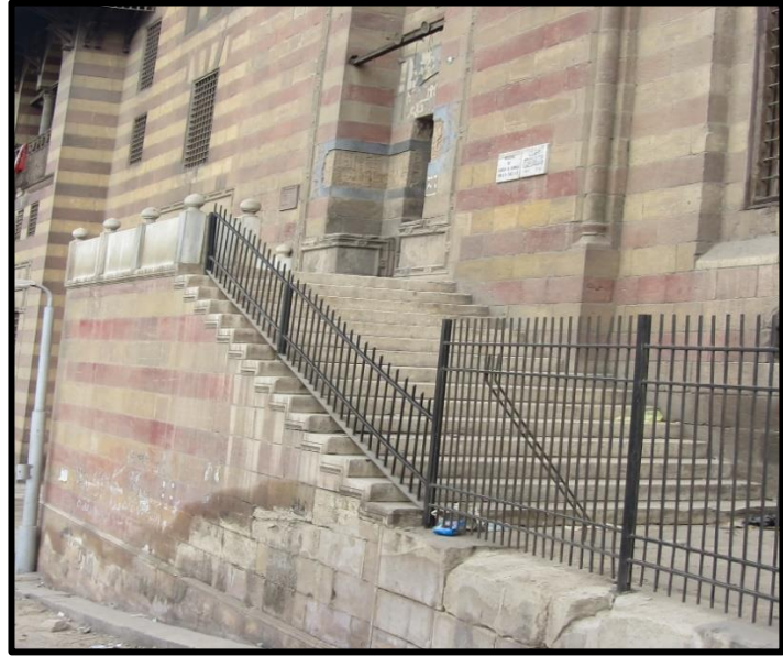
لوحة رقم (30): الواجهة الرئيسية لمدرسة قانى باى الرماح بميدان القلعة ويظهر بها عمود مخلق بناصية المدخل الرئيسي من جهة اليسار (تصوير الباحث)
