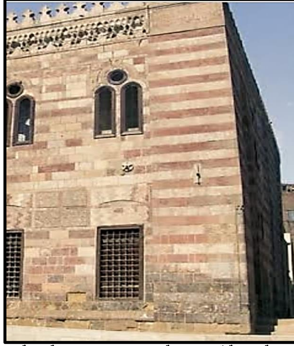
لوحة رقم (17): العمود المخلق بناصية مدرسة قايتباى بقلعة الكبش عند التقاء واجهة القبلة بالواجهة الشمالية الشرقية (تصوير الباحث)
