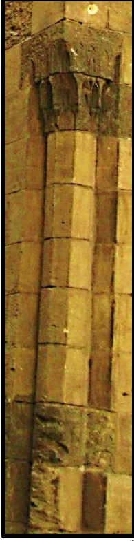
لوحة رقم (6): عمود مخلق بناصية قبة الدفن بمدرسة قانباى المحمدى (تصوير الباحث)
