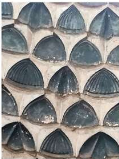
لوحة رقم (١٩): تفصيل لمقرنصات مناطق انتقال القبة. (تصوير الباحث)
