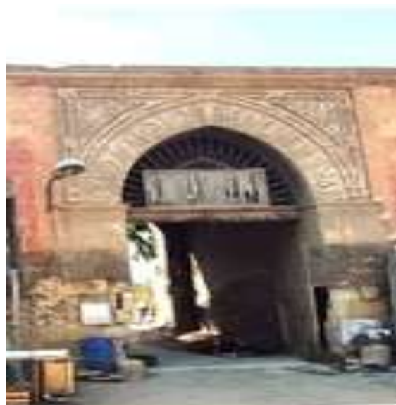
لوحة رقم (٤): المدخل الرئيسي للمدفن يتوسط الواجهة الشمالية الغربية. (تصوير الباحث)
