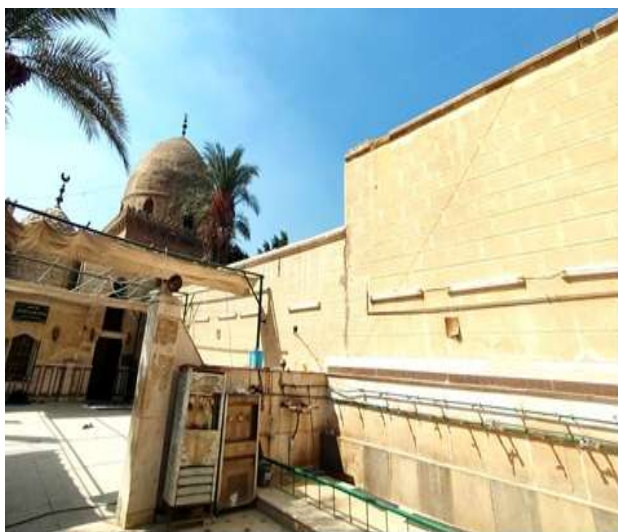
لوحة رقم (٣): الواجهة الشمالية الشرقية لقبة المدفن. (تصوير الباحث)
