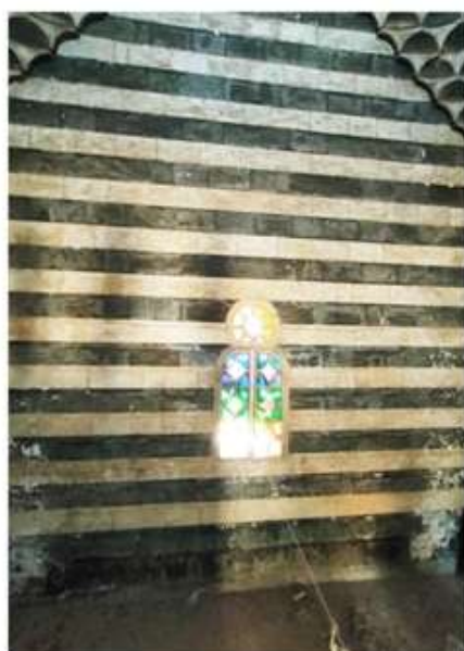
لوحة رقم (١٧): الجدار الجنوبي الغربي لمربع قبة الدفن ويظهر به نظام الأبلق. (تصوير الباحث)
